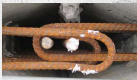
Détail clavetage entre voiles courbes.
